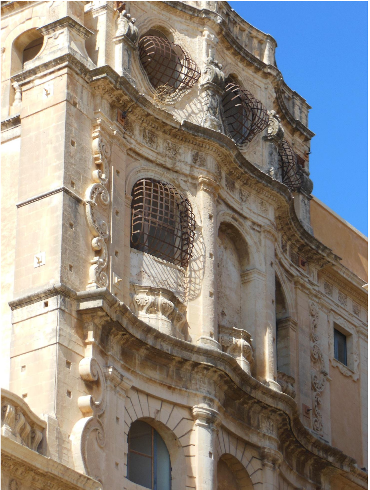
Noto 10/10/2012 Sul Campanile
